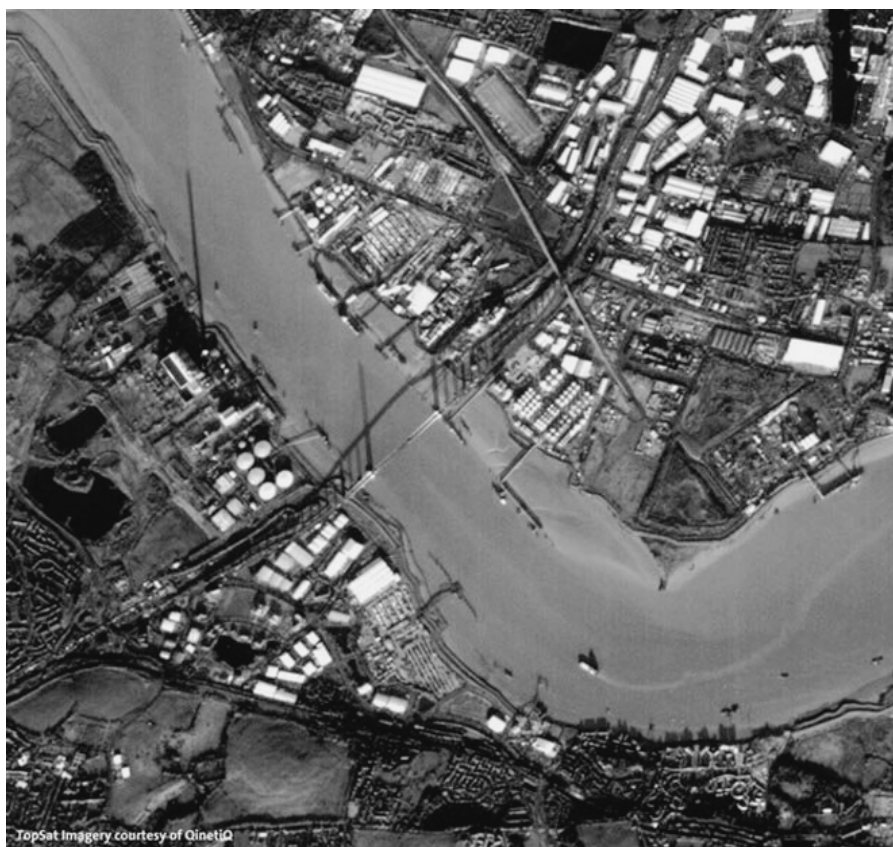
Dit TopSat beeld (7 december 2005, 10:03 uur, origineel in kleur, 5m resolutie) toont bijvoorbeeld het verkeer op de brug (auto's tellen) en schepen die er varen. Met enige voorkennis, dit is de Dartford Crossing, is het bekend dat het de Queen Elizabeth II brug is en kunnen bijvoorbeeld winkelcentra en nutsbedrijven worden onderkend. De schepen varen van de Thames riviermonding langs de Tilbury dokken. [QinetiQ]
