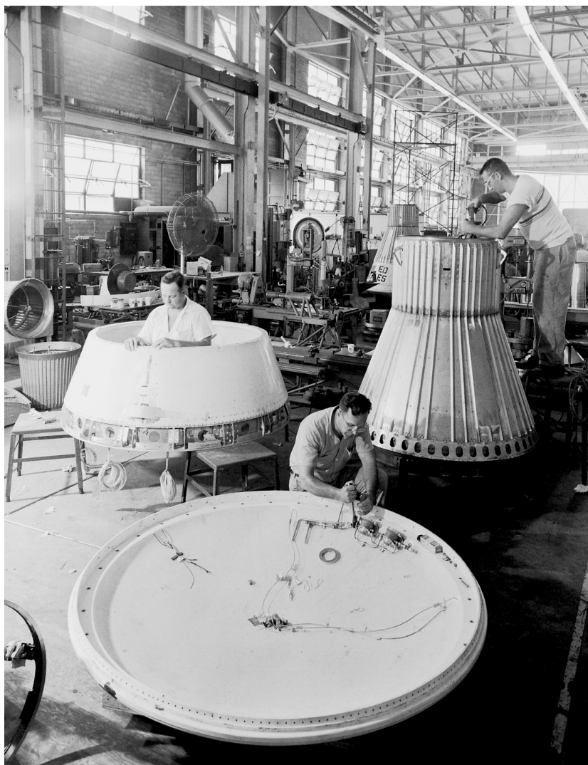
Technici werken aan een prototype van de Mercury capsule in een werkplaats van het Langley Research Center. [NASA]
